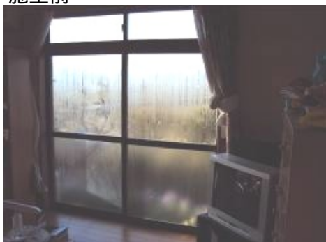
欄間付掃き出し窓、硝子単板ガラス3mm
