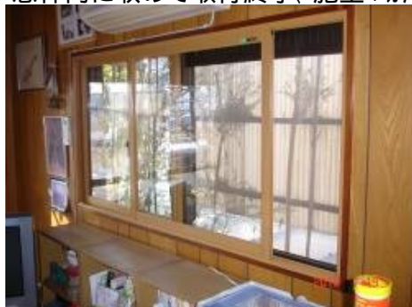
窓枠内に収めて取付終了、施工1ヵ所約1時間。
