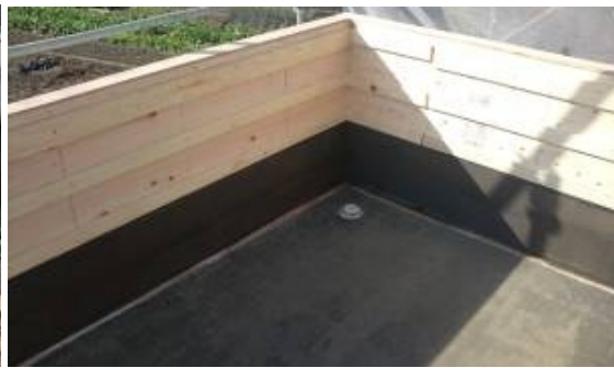
合板で下地復旧しシート防水立ち上げ
