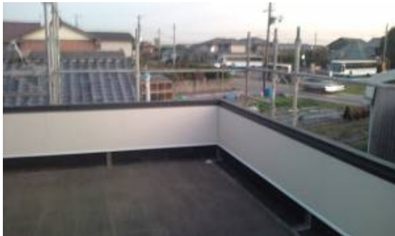
修理完了です
