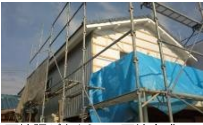
下地胴ぶちをうって下地完成
