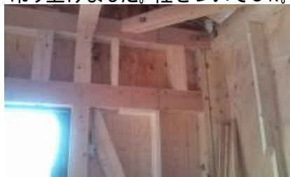
大開口部に合わせ梁で補強します
