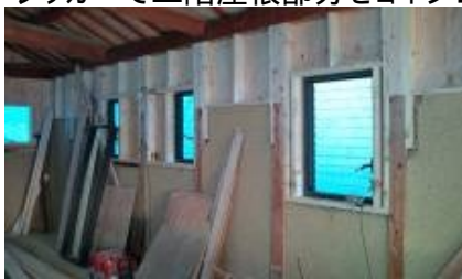
継いだ柱を補強します
